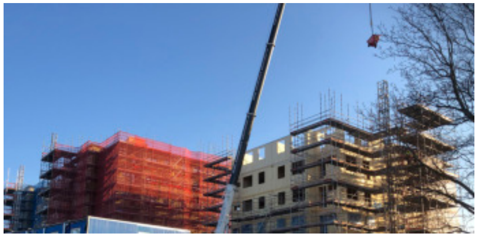
Figur 3: Pågående stomresning av det tredje flervåningshuset i Mellansverige.
