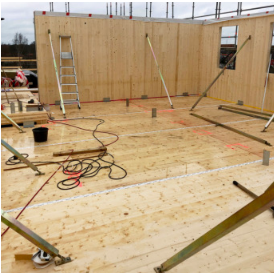
Figur 8: Pågående montage med vatten kvar på bjälklaget efter nederbörd i Mellansverige.
