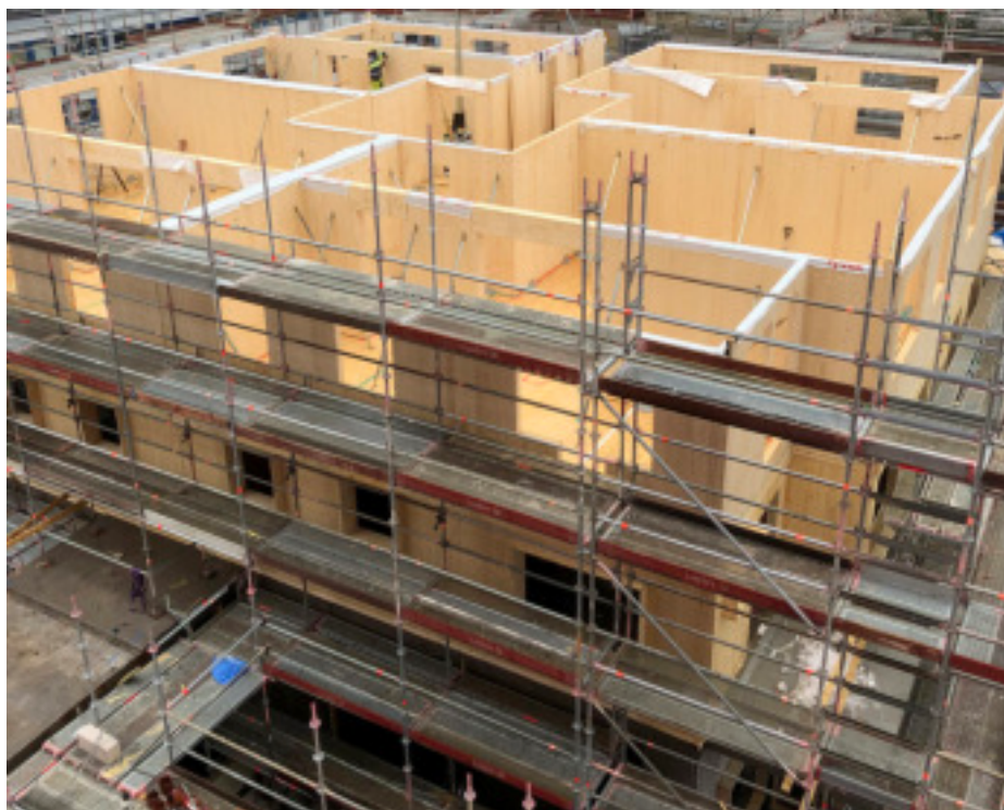
Figur 1: Pågående byggnation med KL-trästomme utan väderskydd.
