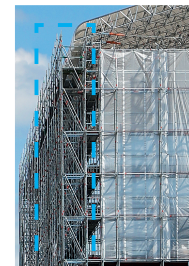
Exempel på stagning och konsol
